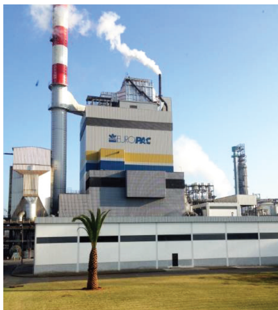
Central de energia
